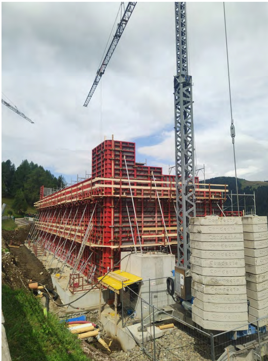
Situazione del cantiere del sovrappasso il giorno 25 luglio 2027; l'impalcato sarà realizzato in settembre per ridurre i disagi alla viabilità turistica
