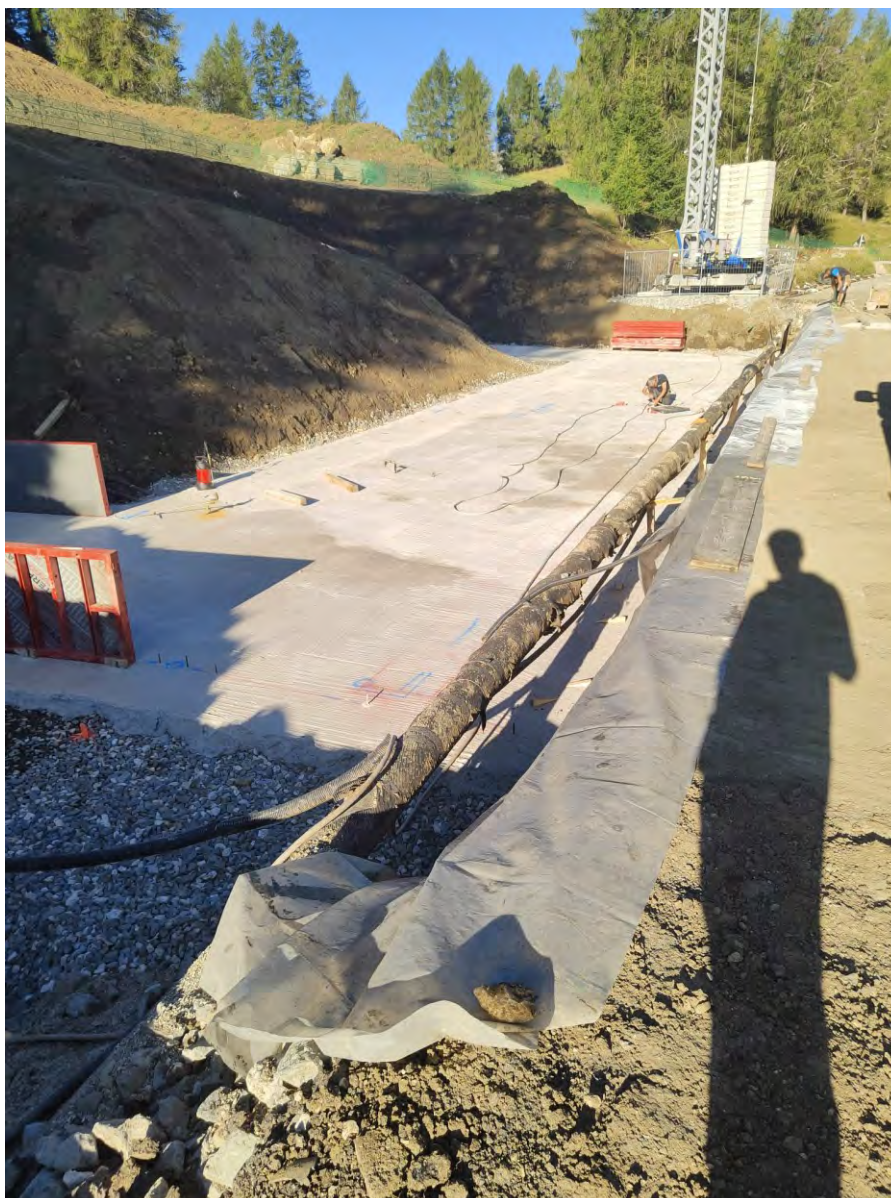
Situazione del cantiere del sovrappasso il giorno 29 luglio 2027; la tubazione del gas da controltubare è in primo piano
