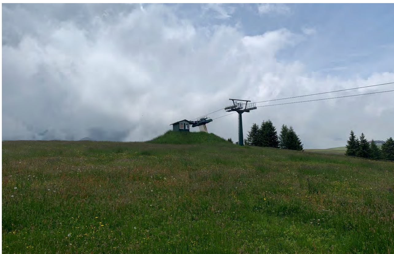
Foto 10 Vista della attuale stazione di monte.
