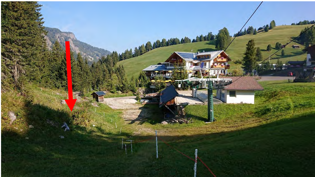
Foto 1 Vista della stazione di valle della seggiovia attuale. La freccia rossa indica la zona dove verrà posizionata la nuova stazione di valle
