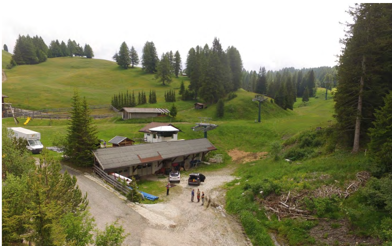
Foto 6 Vista d'insieme della stazione di valle attuale
