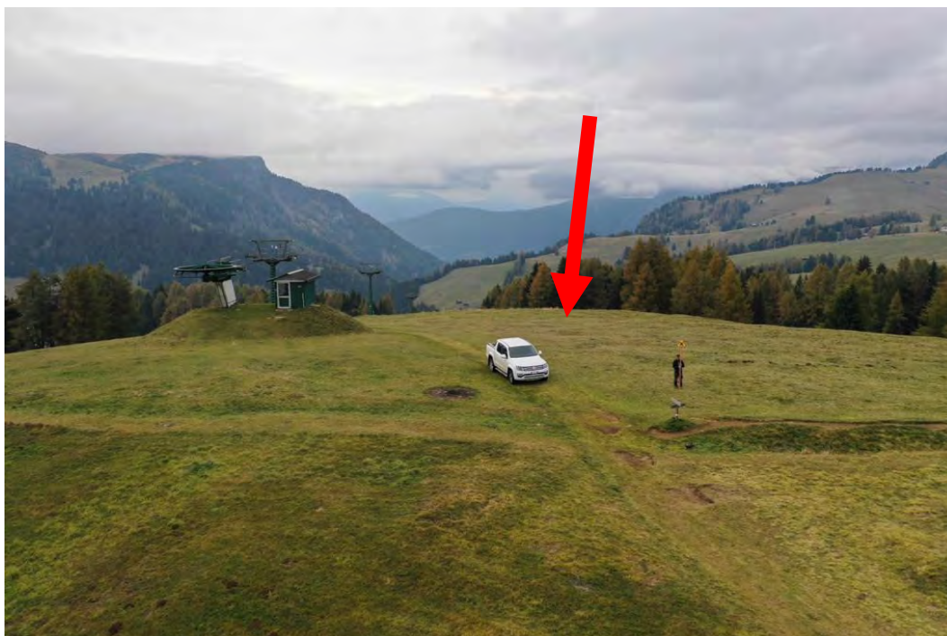
Foto 7 Vista della stazione di monte della seggiovia attuale. La freccia rossa indica la posizione della nuova stazione di monte.
