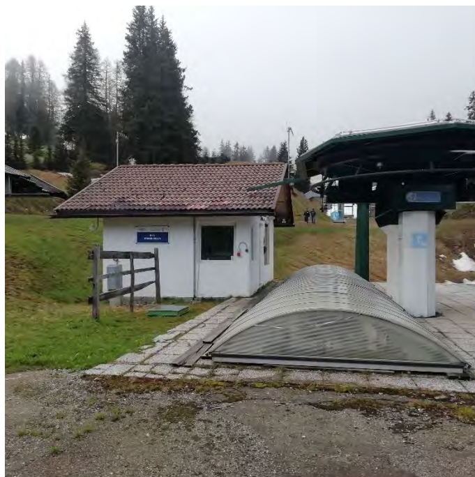
Foto 3 Vista della stazione di valle attuale e relativa cabina di comando. Tali strutture verranno completamente rimosse.
