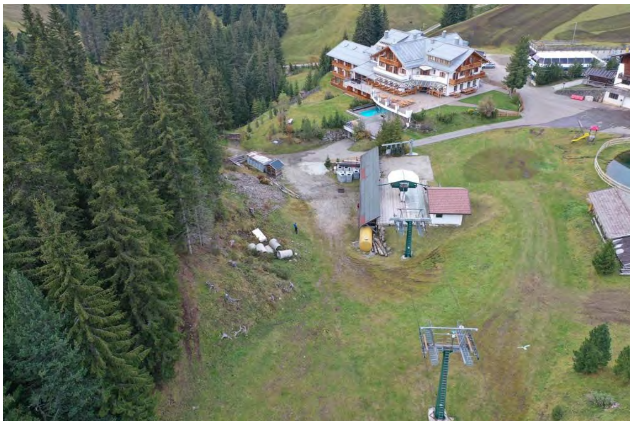
Foto 5 Vista d'insieme della stazione di valle attuale
