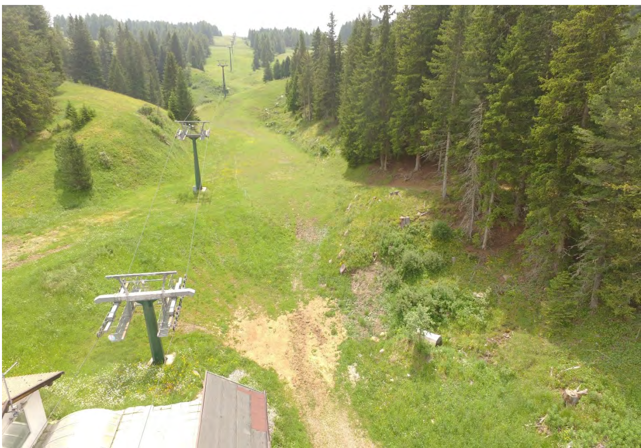
Foto 16 Vista della linea da valle verso monte
