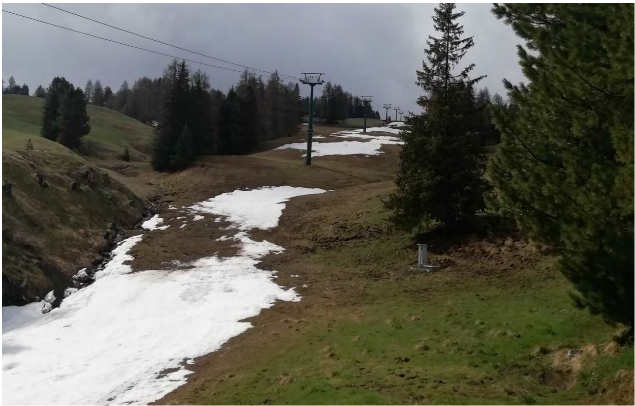
Foto 13 Vista della linea attuale dell'impianto da valle verso monte.
