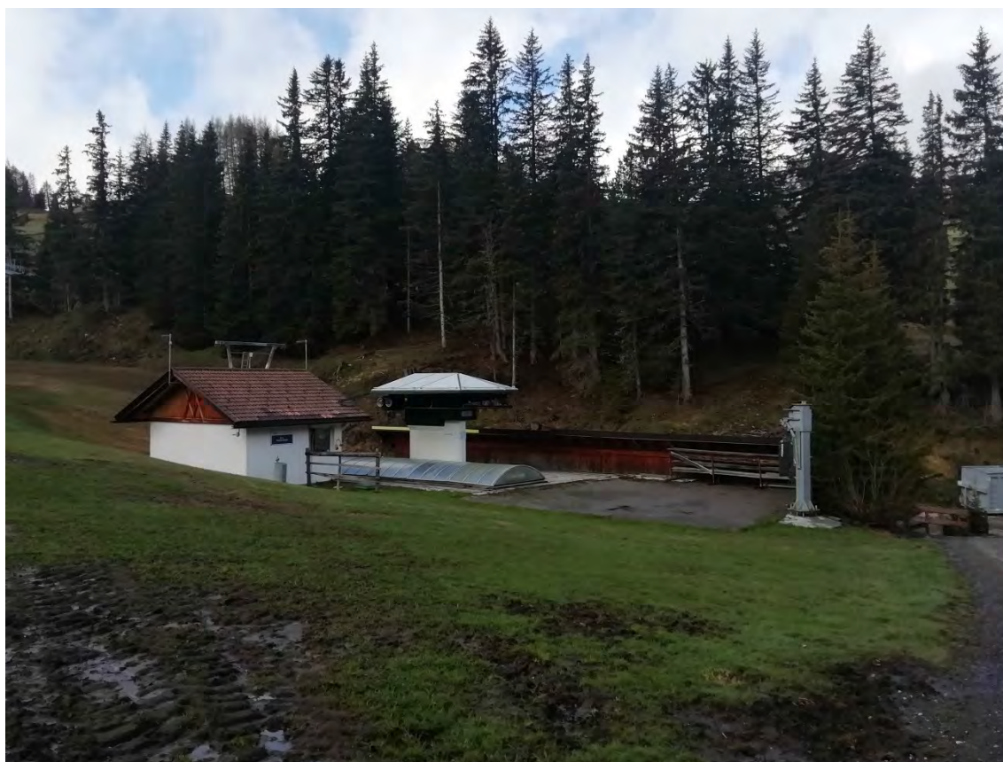
Foto 4 Vista della stazione di valle attuale dai pressi della stazione di valle della seggiovia "Monte Piz".
