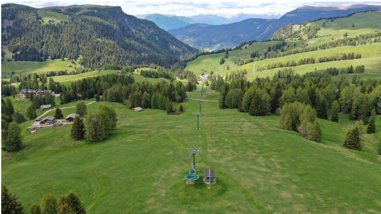
Foto 14 Vista della linea attuale dell'impianto da monte verso valle.
