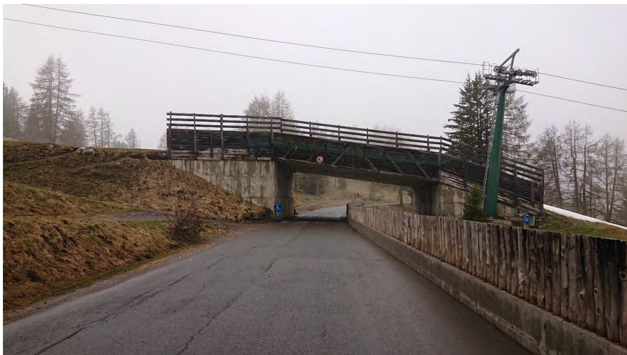
Foto 11 Vista dell'attuale sottopasso sulla strada Compaccio.
