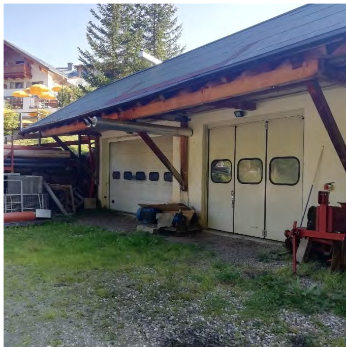
Foto 2 Vista dei magazzini esistenti sotto la stazione di valle attuale. Tali magazzini verranno completamente demoliti.
