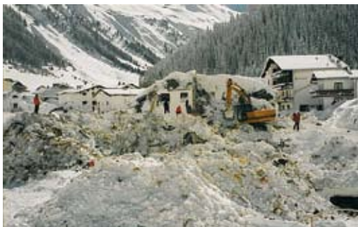
Abb. 34: Blick auf ‚Winkl‘ mit dem völlig zerstörten Haus ‚Litzner‘ (Quelle: Mair, 2008)
