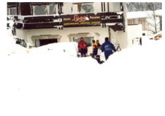
Abb. 37: Schwer beschädigtes Hotel ‚Luggi‘ (Quelle: Mair, 2008)
