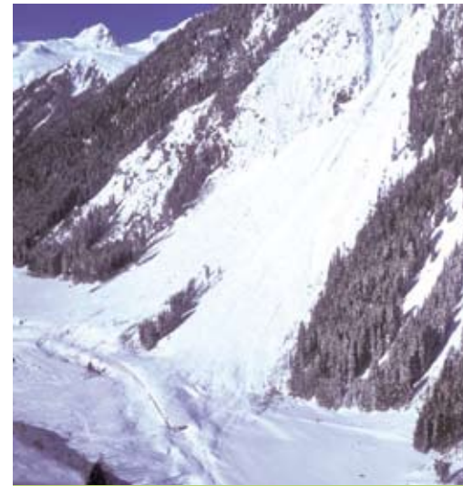
Abb. 9: Beispiel einer zu kurzen Galerie im Auslaufbereich der Pleisen-Lawine.
