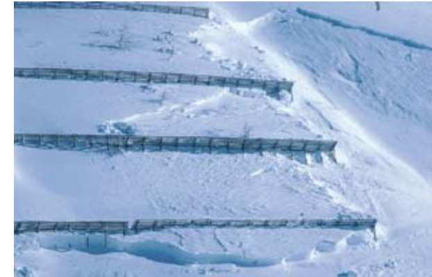
Abb. 1: Lawinanbruch neben der Verbauung Nolle, Oberwald, Kt. Valais am 12. Februar 1999. Im Verbau wurde der Anbruch durch die Stützwerke erfolgreich verhindert.
