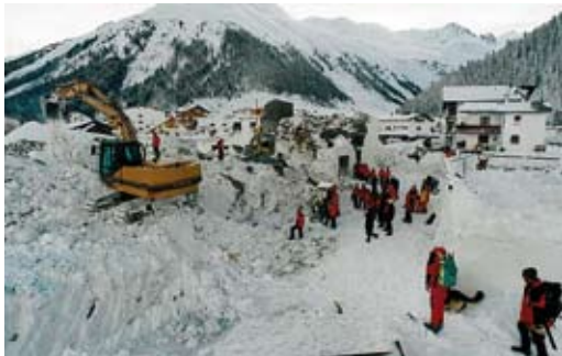
Abb. 33: Haus ‚Litzner‘ vor dem Lawinenabgang (oben), Foto 50: Haus ‚Litzner‘ völlig zerstört (unter dem Bagger) nach dem Lawinenabgang (unten), (Quelle: Mair, 2008)
