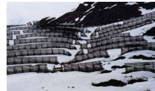
Abb. 4: Burtschakopflawine – Schaden durch Lawinenabgang oberhalb der Verbauung trotz darüberliegendem Schutzdamm
