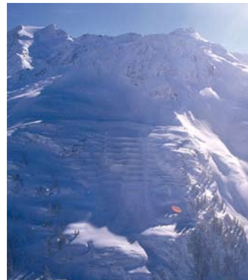
Abb. 4: Burtschakopflawine – Schaden durch Lawinenabgang oberhalb der Verbauung trotz darüberliegendem Schutzdamm
