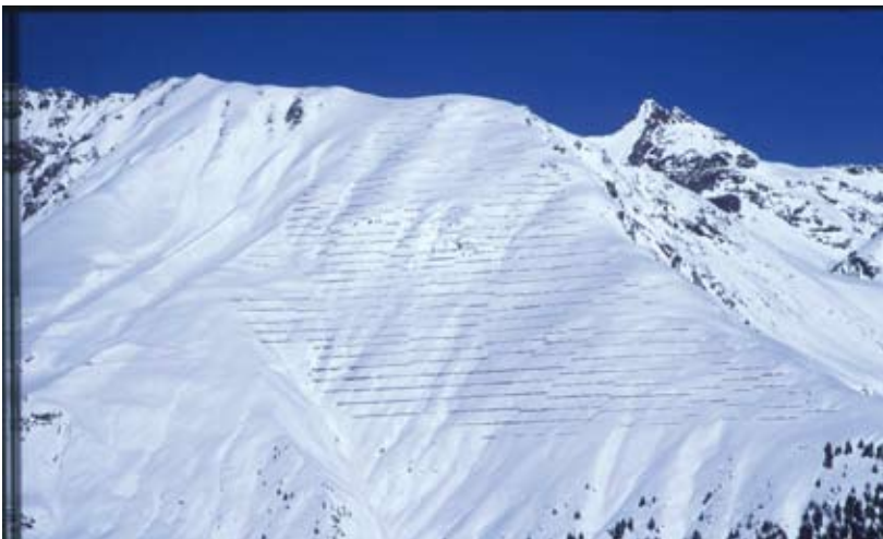
Abb. 6: Verbauung Madleinlawine, Gde. Ischgl, Zustand im März 1999
