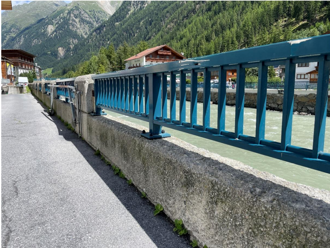
Abbildung 9: Hochwasserleitdamm im Bereich der Brücke 21 orographisch links [16]
