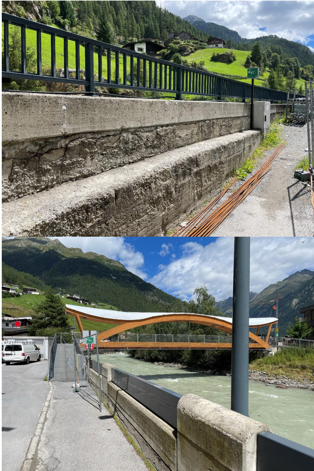
Abbildung 8: Hochwasserleitdamm im Bereich der Brücke 19 orographisch links [16]
