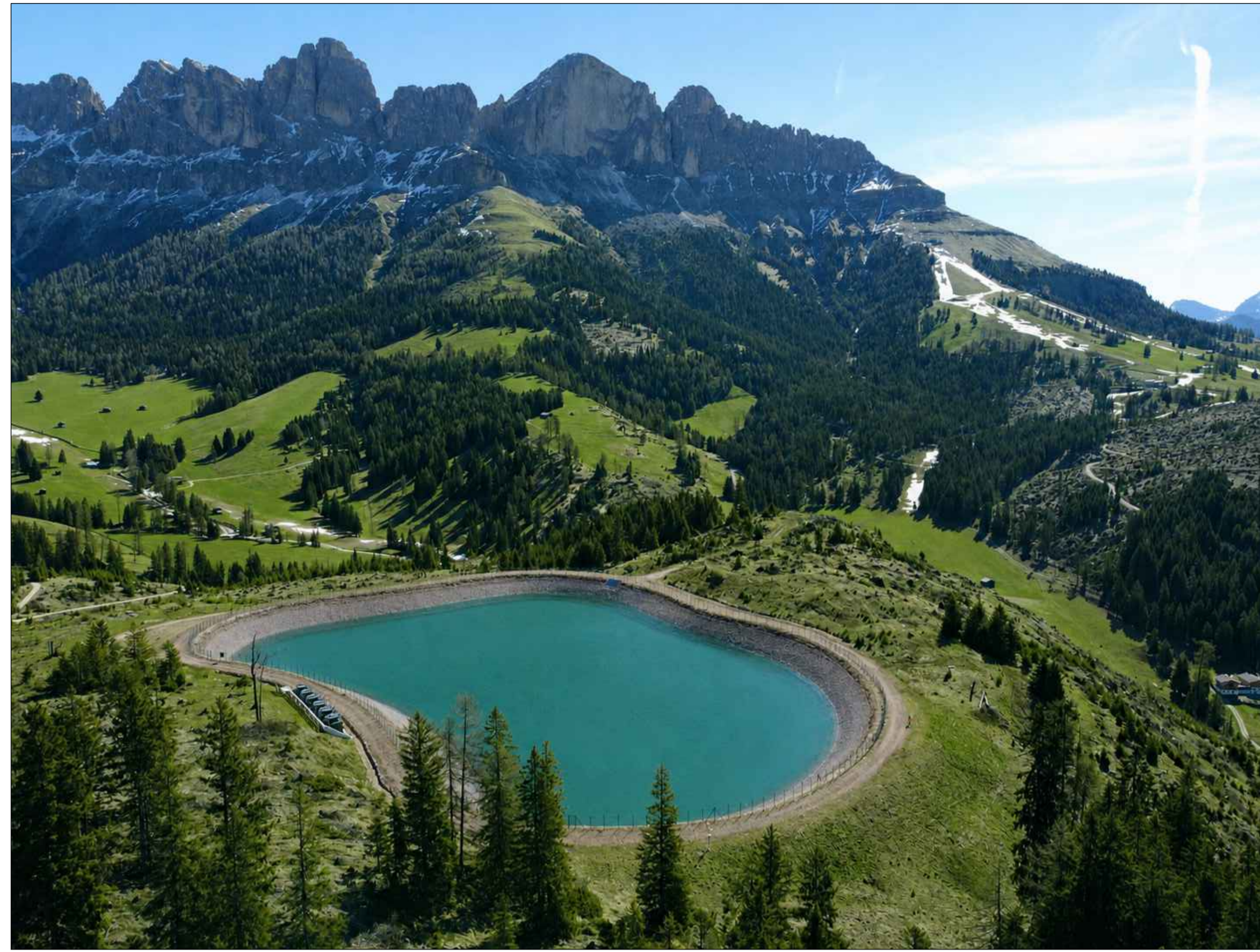
BLICK RICHTUNG ROTWAND BESTAND | VISTA VERSO RODA DI VAËL STATO ESISTENTE
