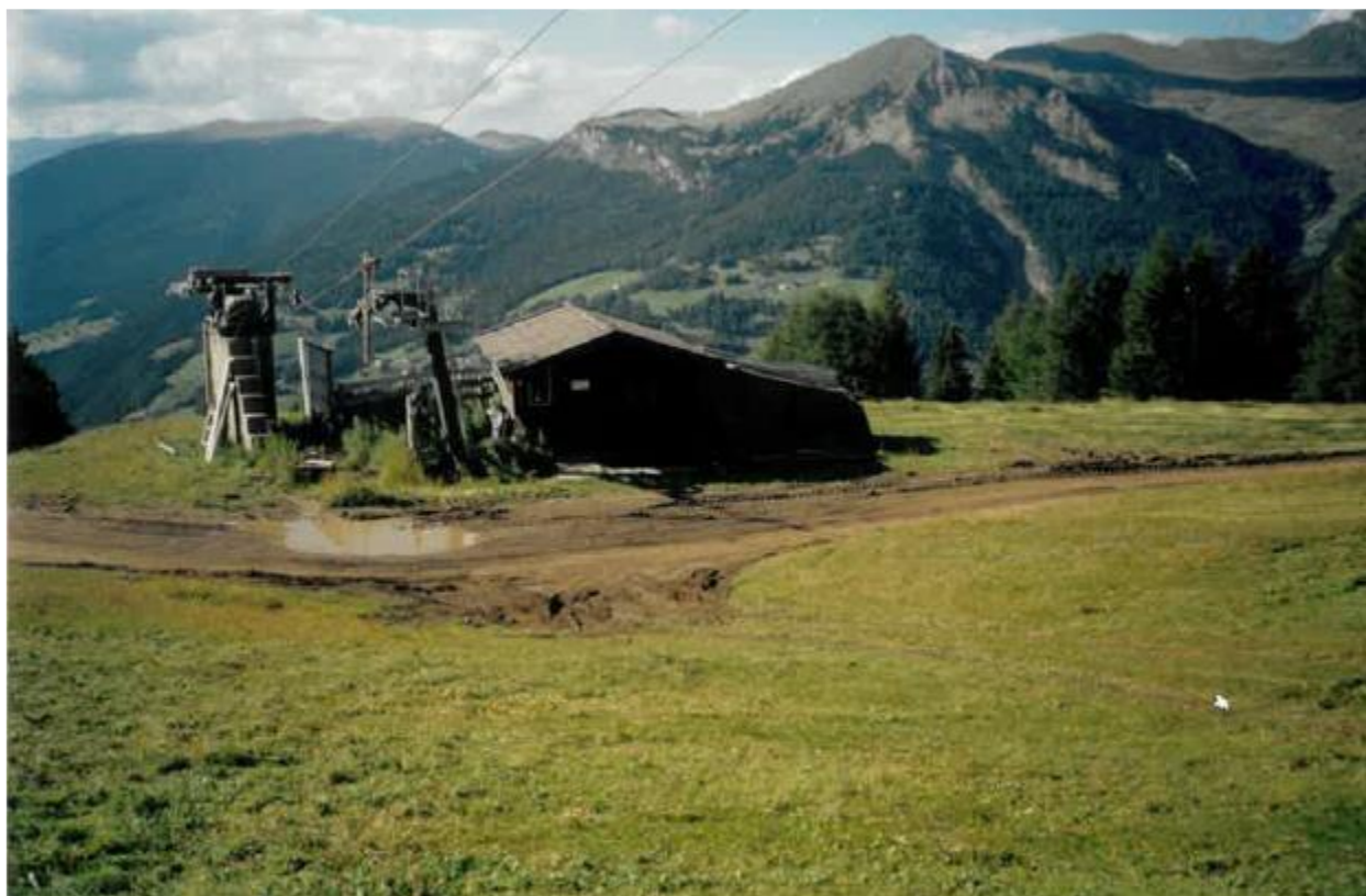
Figura 7: Stazione di valle scivovia Bruno con annesso manufatto cabina di comando e cabina di potenza
