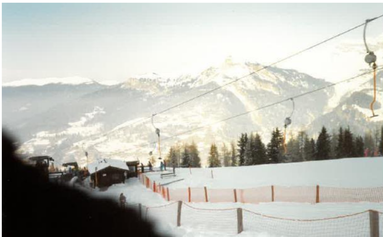
Figura 11: vista da monte verso valle della linea sciovia Bruno
