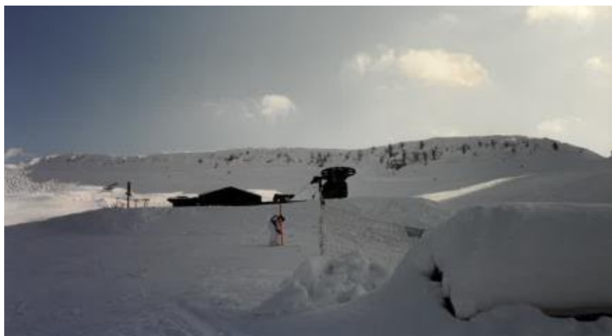
Figura 12: vista da valle della stazione di partenza della sciovvia Bruno
