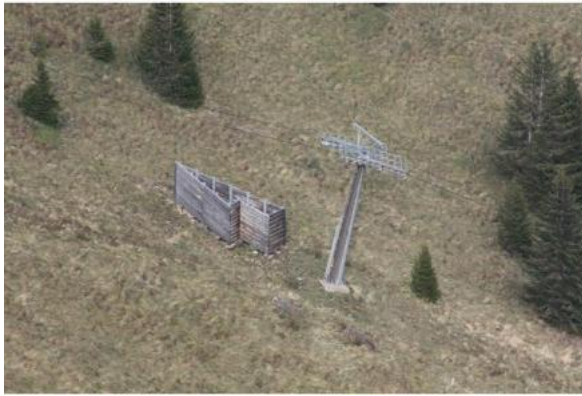
Figura 79: Esempio di cuneo diretto di difesa, a sinistra, e reti da neve, sulla destra.
