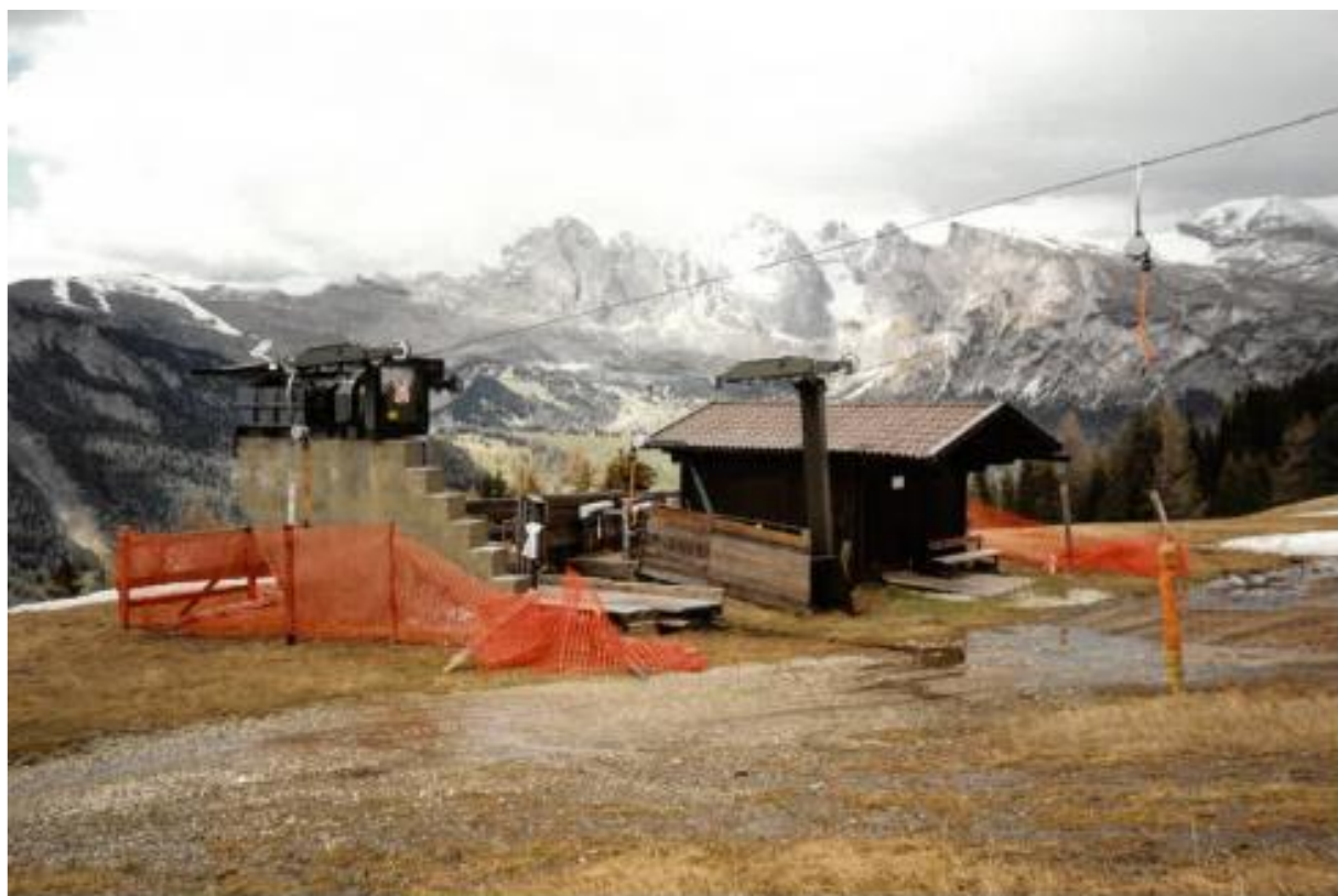
Figura 9: Stazione di valle sciovvia Bruno con annesso manufatto cabina di comando e cabina di potenza
