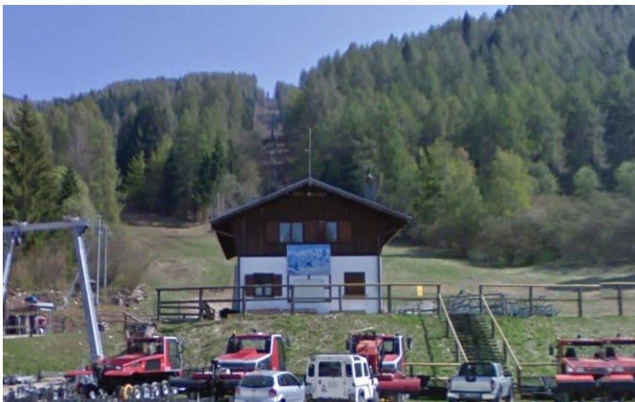
Figura 84: seggiovia Col Canil nel 2011, Belluno, Nevegàl. Immagine Google street view.
