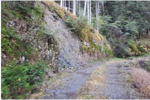
Kleinräumige Translationsrutschung direkt nach der Querung des Reipertingerbachs.
