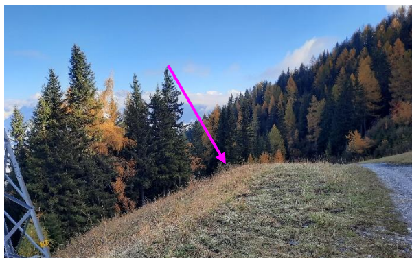
Baufläche von Stütze II-06 „Kronplatz 2“.
