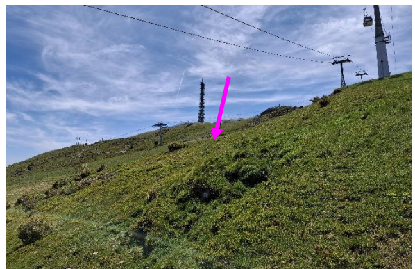
Baufläche von Stütze II-10 „Kronplatz 2“.
