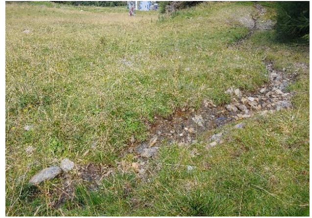
Wasseraustritt direkt talseitig der Baufläche von Stütze II-07.
