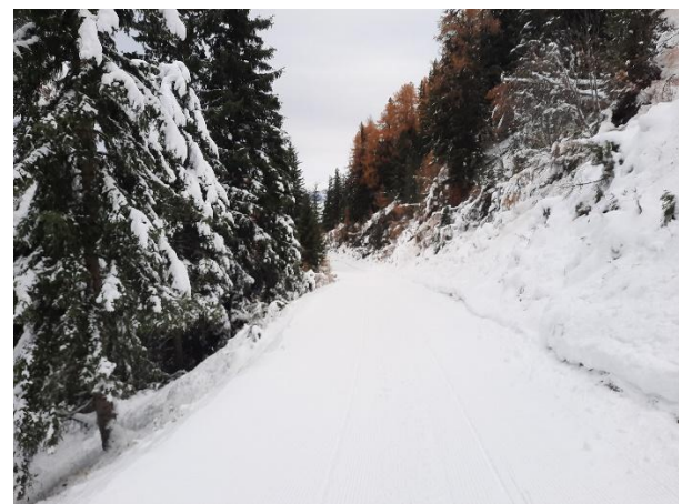
Bestehender Skiweg entlang des bergseitig steilen Böschungsanschnitts.
