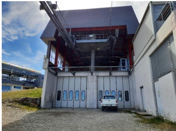
Nordansicht der bestehenden Bergstation.
