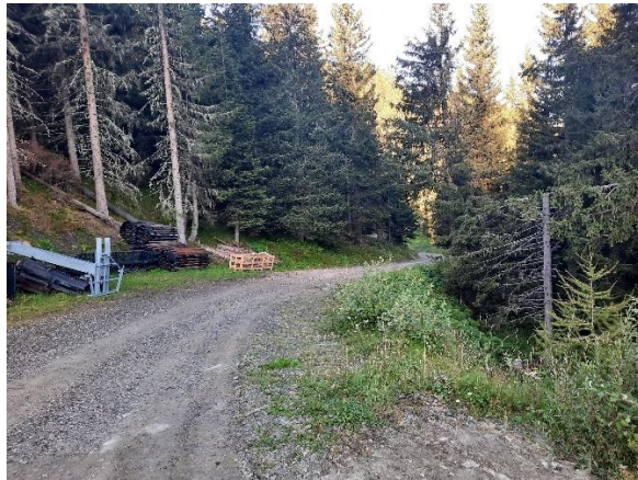
Bestehender Forstweg „Hernegg“ direkt westlich der bestehenden Garage. Im linken Bildausschnitt leichter Säbelwuchs der Bäume durch oberflächliche Kriechbewegungen.
