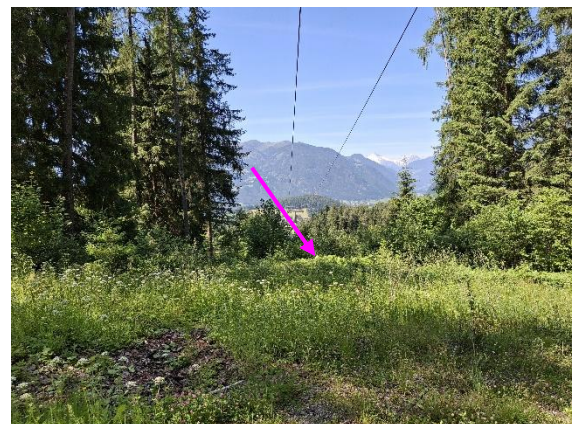
Baufläche von Stütze I-06 „Kronplatz 1“.
