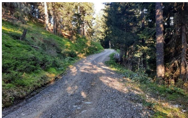
Verlauf Forstweg „Korer“ im Bereich der Anbindung an die geplante Piste „Kronplatz 1+2“.
