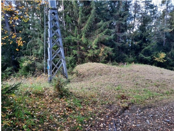
Bestehende Stütze im Bereich der Baufläche von Stütze I-04 „Kronplatz 1“.
