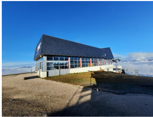
Südostansicht der bestehenden Bergstation.
