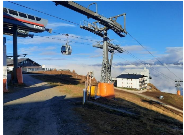
Baufläche der Stütze II-12 direkt talseitig der bestehenden Talstation.
