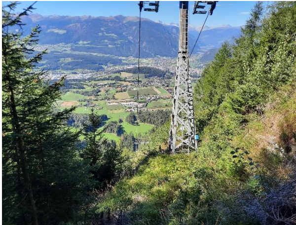
Baufläche von Stütze I-09 „Kronplatz 1“ talseitig der bestehenden Stütze 15.
