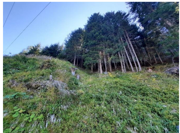
Übergang in die tiefgründige Massenbewegung (linker Bildausschnitt) rd. 50 m bergseitig des geplanten Stützenstandorts.
