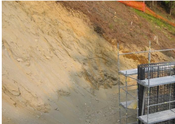
Foto 5: Fluvioglaziale Sedimente in der Baugrube der Bergstation „Korer“.
