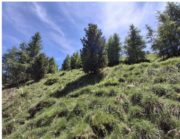
Baufläche von Stütze II-08 „Kronplatz 2“.
