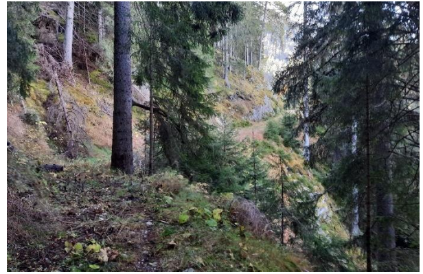
Übergangsbereich des bestehenden Forstwegs zur neu zu errichtenden Zufahrtsstraße.
