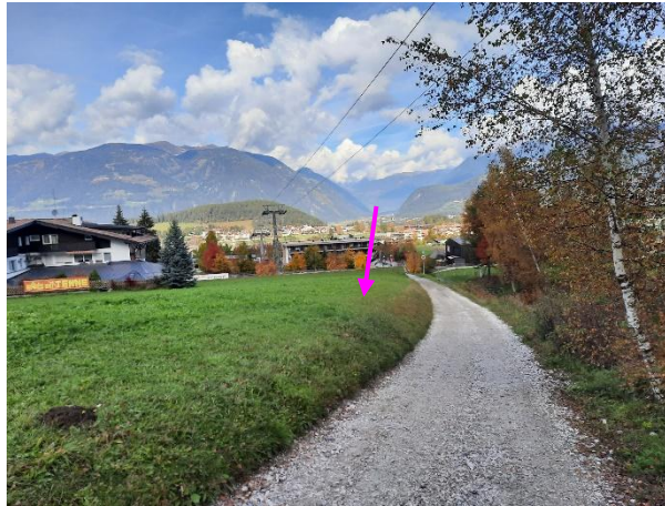
Position Stütze I-03 „Kronplatz 1“.
