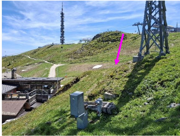
Baufläche von Stütze II-11 „Kronplatz 2“.
