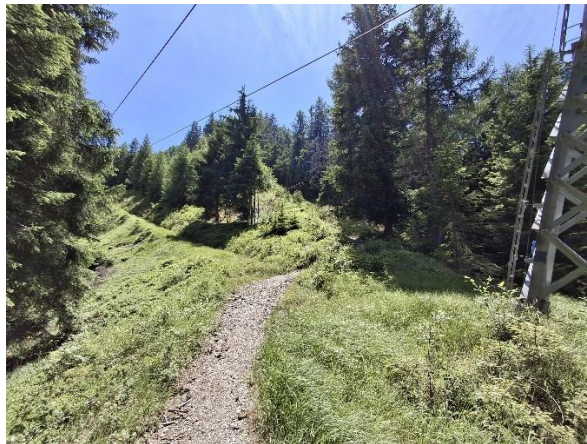
Baufläche von Stützen I-10 bis I-12
