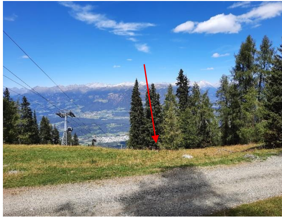
Baufläche von Stütze II-07.
