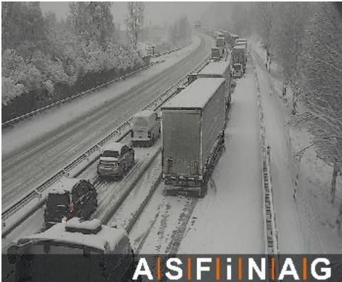
Hauptmautstelle Gleinalm auf der A9 bei KM 134.6
