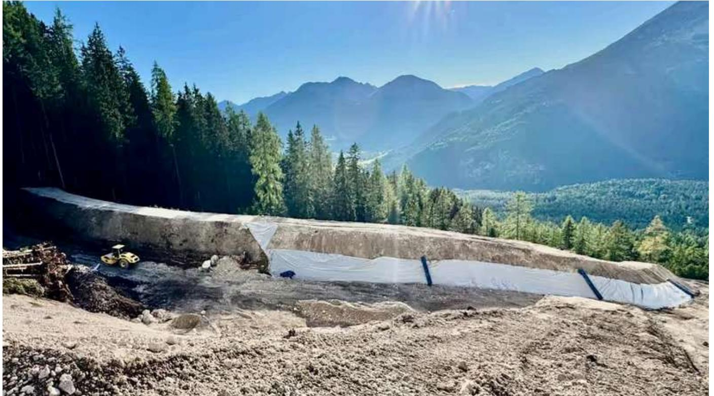
Auf rund 200 Metern Länge und bis zu fünf Metern Höhe versperrt der neue Damm den Gesteinsmassen künftig den Weg entlang der Piste ins Tal.
