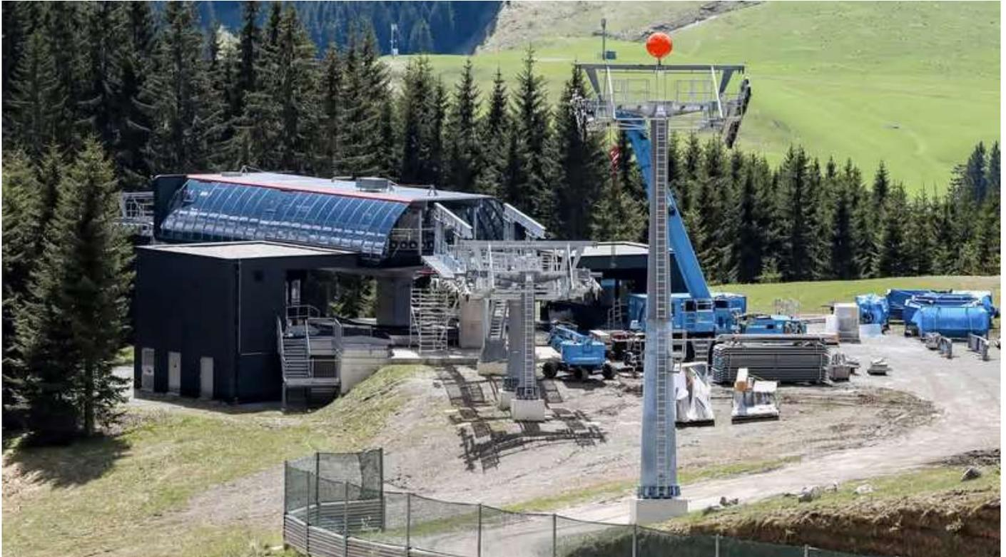
Die bisherige Bergstation der Oberen Karbahn Sektion I wird zur Mittelstation. © Bergbahnen Berwang
