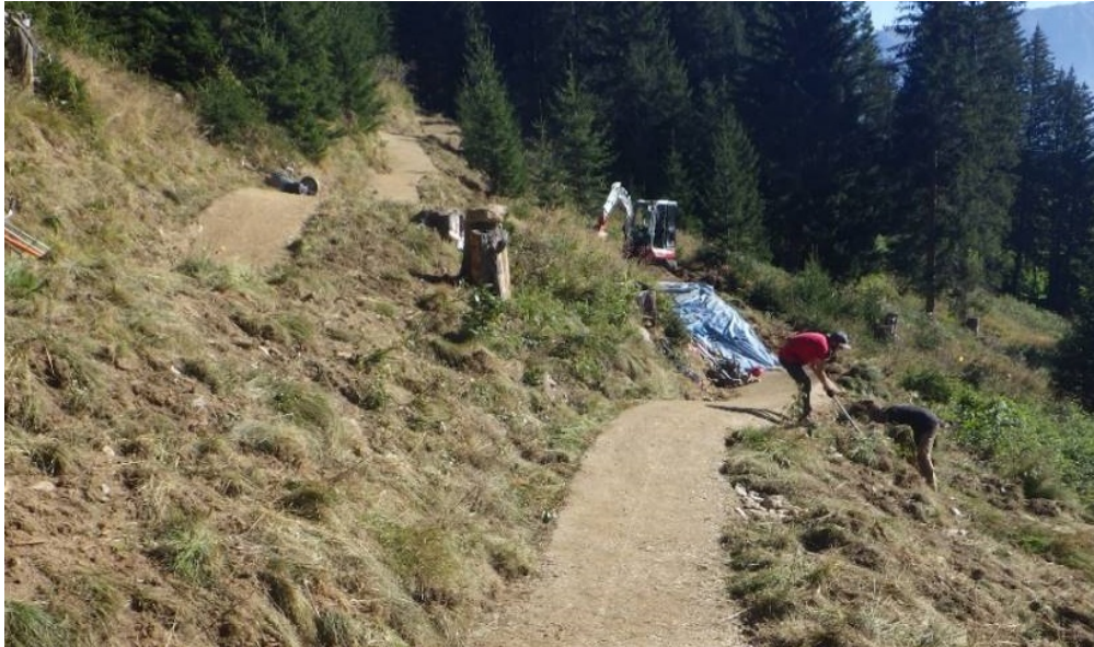
Abb. 10: Die Rekultivierungsarbeiten (genaue Positionierung, tw. Fixierung der Vegetationssoden) werden zu einem Großteil händisch ausgeführt (Symbolbilder).
