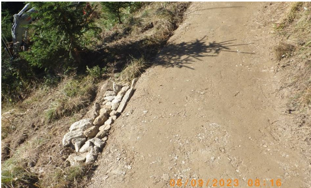
Abb. 9: Muldenförmige, breitflächige Wasserausleitung mit Erosionsschutz aus Steinen (Symbolbilder).
