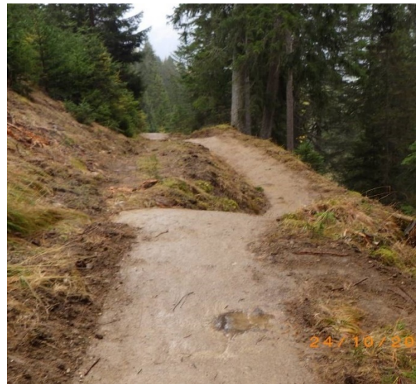
Abb. 8 Sämtliche Rasensoden werden lagerichtig wiederverlegt (Symbolbilder).
