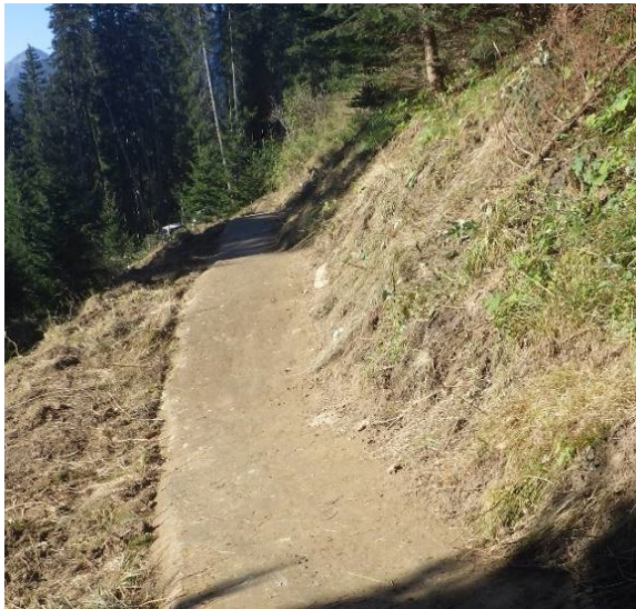
Abb. 8 Sämtliche Rasensoden werden lagerichtig wiederverlegt (Symbolbilder).
