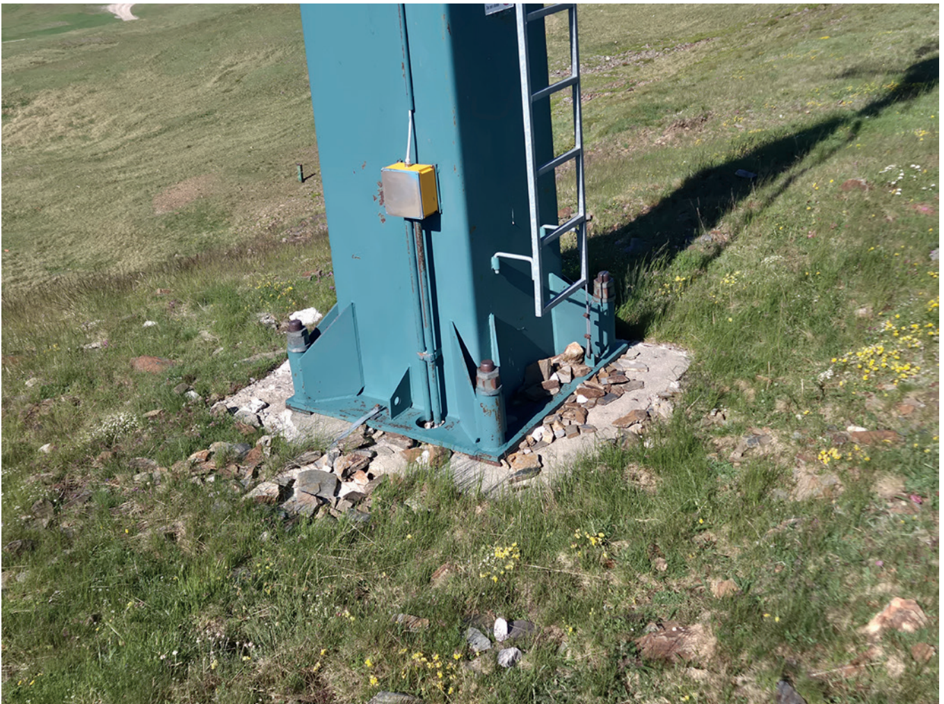
Abbildung 2: Ansicht der bestehenden Stützen mit Betonfundament:
