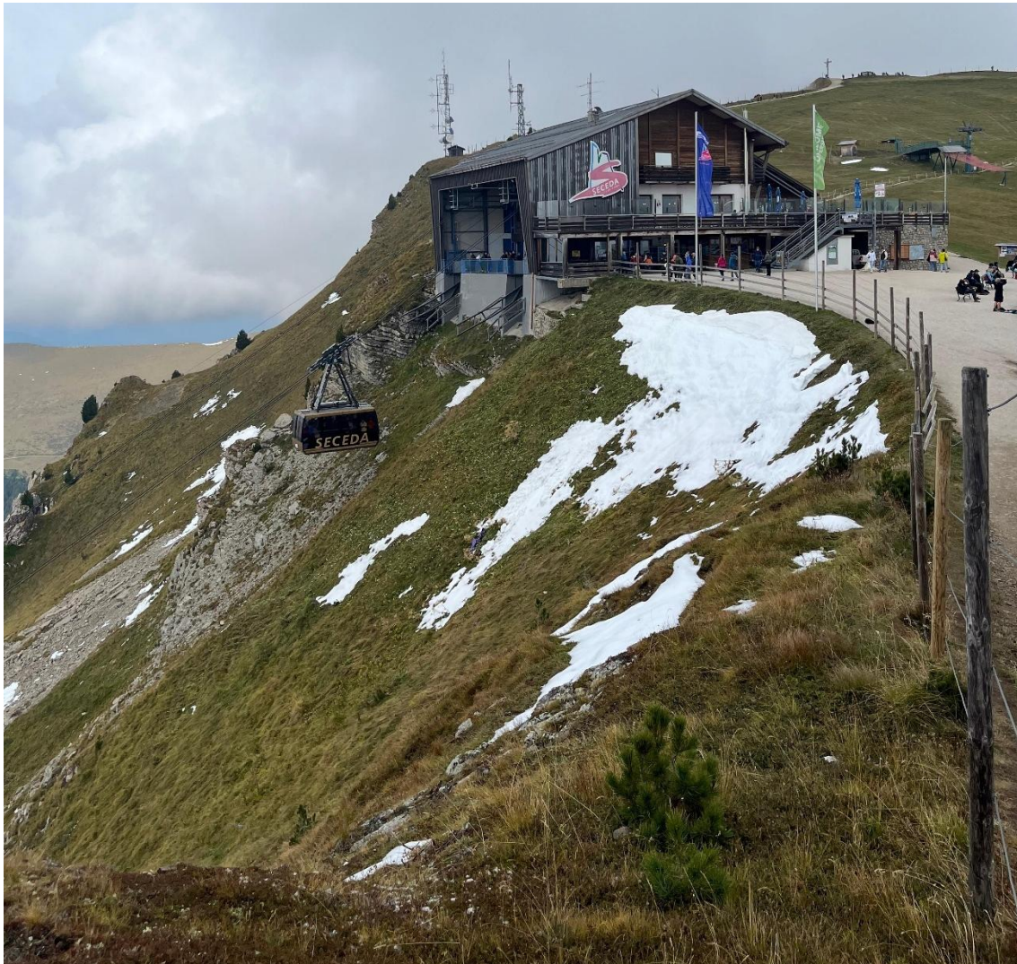
Figura 16 | Attuale stazione di monte, si notano le rocce affioranti e la poca profondità del suolo
