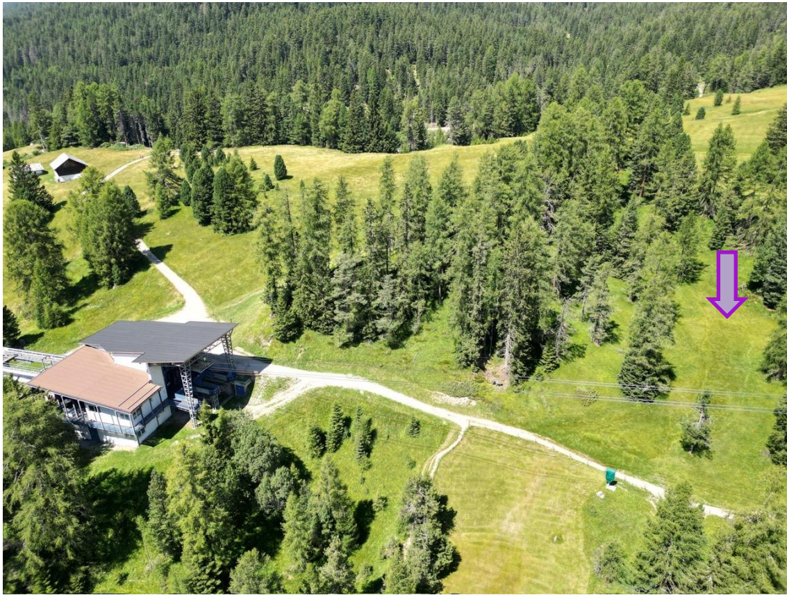
Figura 12 | Vista dell'attuale stazione di valle, sulla destra l'area umida lambita dai movimenti terra in progetto
