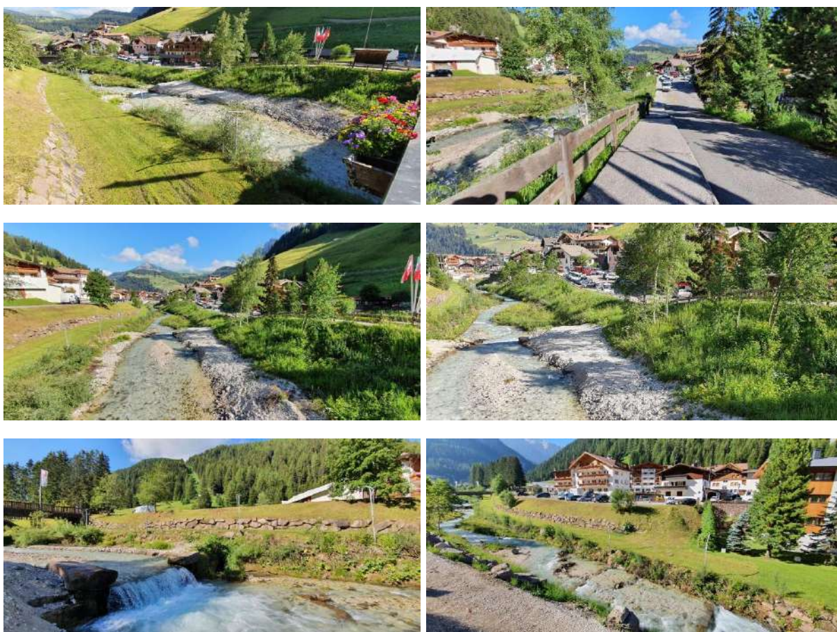
figura 13: Tratto 3. Zona Freina. L'alveo è protetto da sponde e da soglie in massi ciclopici a secco.
