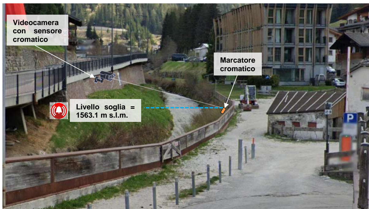
figura 35: Schematizzazione del sistema di allertamento che si attiva nel momento in cui il livello del rio Gardena supera la quota di soglia individuata ad 1.5 m dalla sommità della barriera di protezione in sponda sinistra (quota di 1563.1 m s.l.m.) in corrispondenza della sezione 1. Quando il livello dell'acqua raggiunge la quota di soglia, il marcatore cromatico va completamente sott'acqua, per cui la videocamera non percepisce più il colore ed attiva l'allarme.
